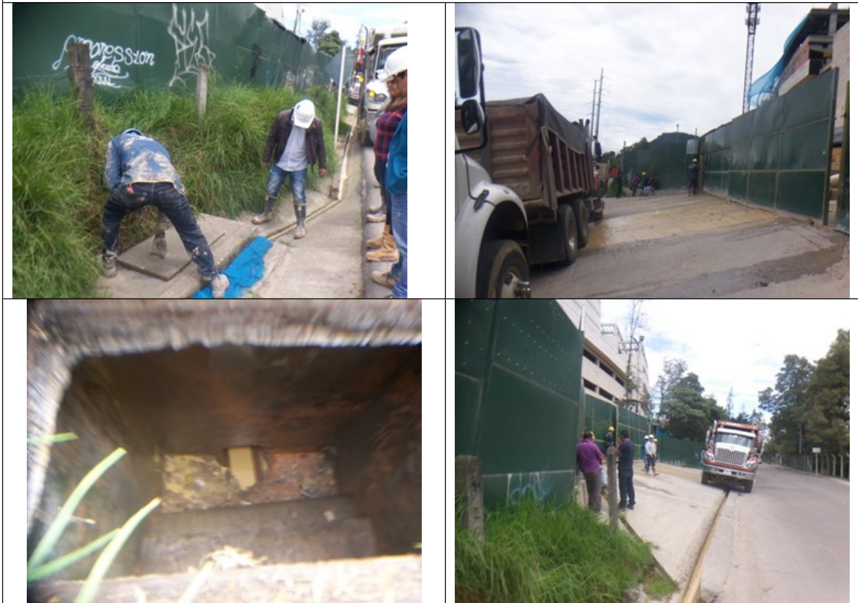
Foto 6 y 7. Presunta afectación a la quebrada Padre de Jesús por la decantación de sedimentos contenidos en el agua procedente de la actividad de lavado de los vehículos relacionados con el proceso constructivo.
